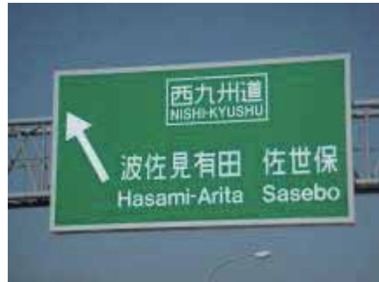
施工後 (シート取付枠を使用)
